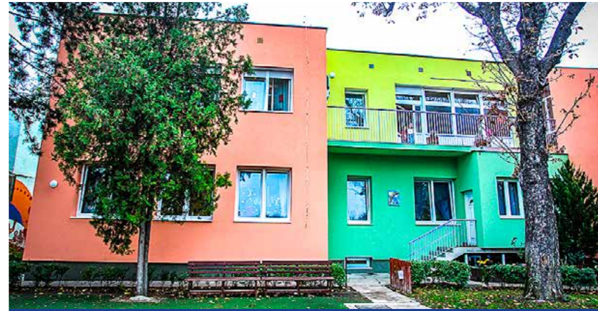
Hőszigetelést kapott a színesre festett homlokzat
