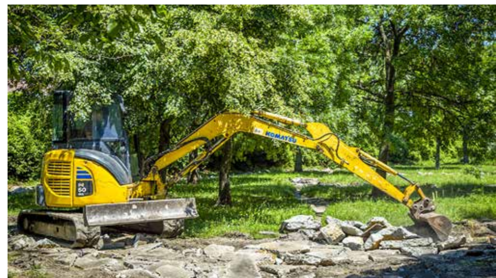
Jelenleg a bontási munkálatok zajlanak
